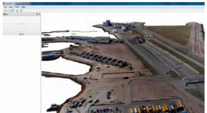
Изыскательские работы с применением БПЛА «Геоскан» при строительстве комплекса защитных сооружений от наводнений (Санкт-Петербург)
